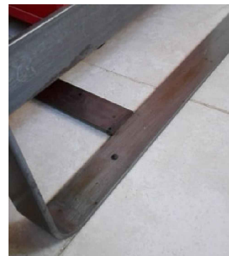
Regatones de goma en la base para evitar la oxidación.
